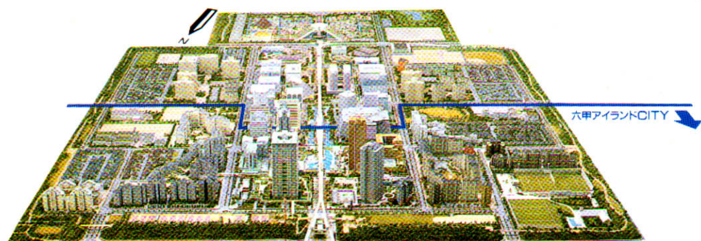
※この写真は神戸市街景を参考に描いた模型です。建物の外観などは実際とは異なる場合があります。 イーストコート3番街 ※六甲アイランドCITY北側(シティビル北側)の臨港道路に大規模道路(地上30m程度の高架道路)の計画があります。
